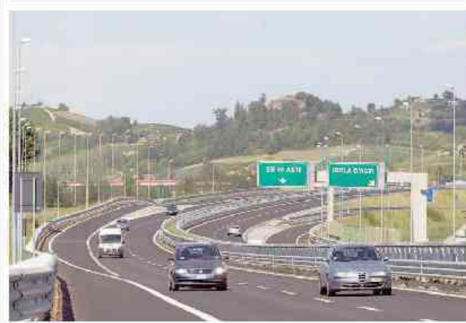
Autostrada Asti Cuneo
